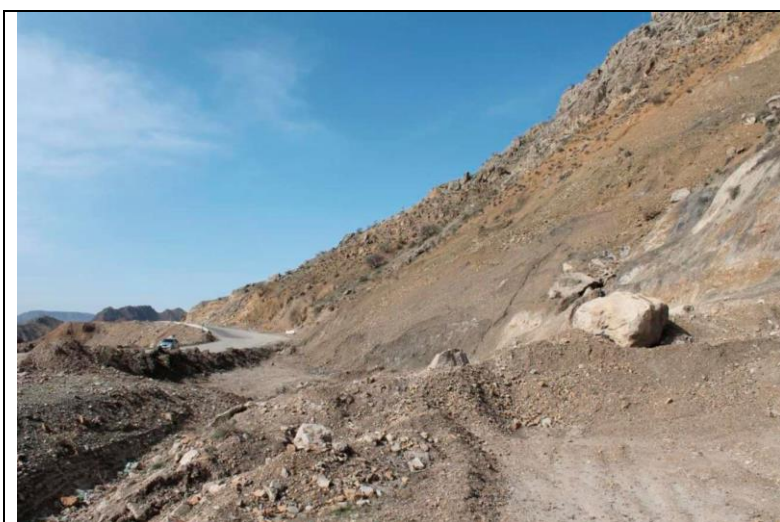
Состояние оползня выше уровня дороги, участок автодороги БО 451 км.
