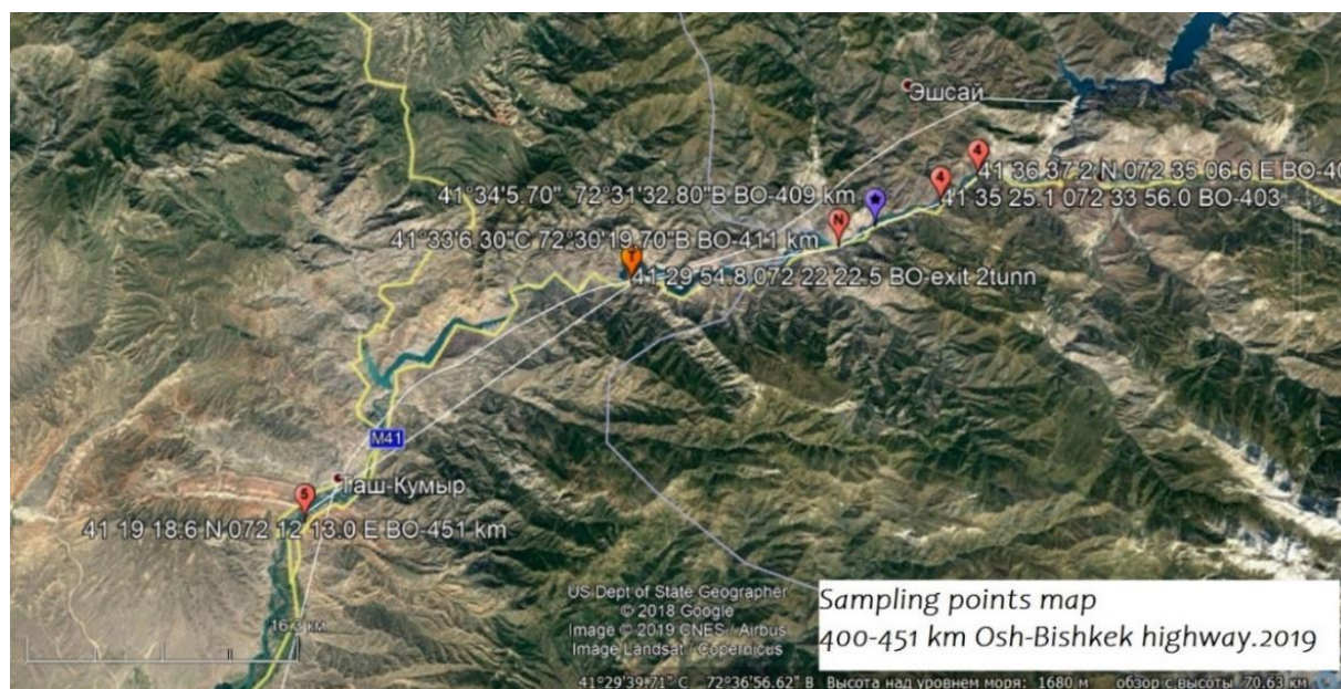
Рисунок 4. Карта отбора проб среды по автодороге БО(атмосферного воздуха, воды и замеров физических воздействий)
