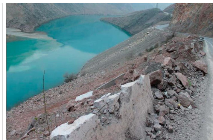
Состояние ограждений и дорожного откоса БО.
